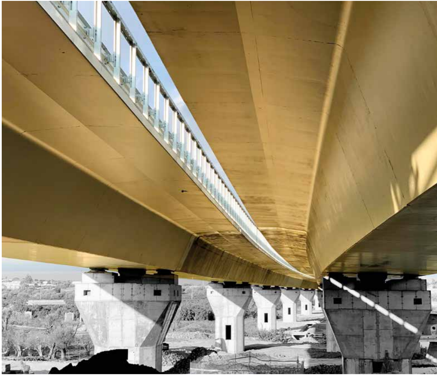
A25 Syracuse-Pozzallo Viaduct Pozzallo
