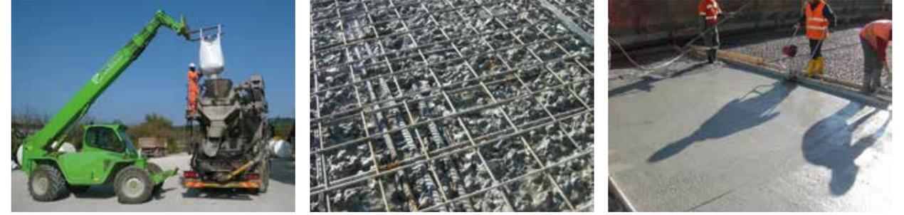
En raison de l'épaisseur élevée des coulées, il est toujours nécessaire que les coulées soient fournies d'une armature.
