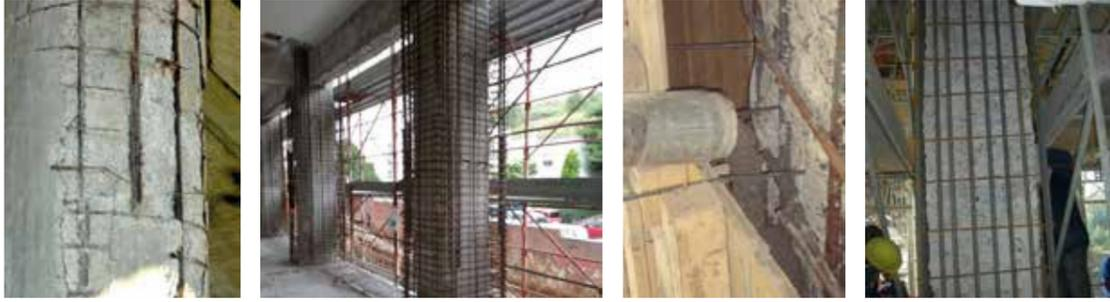
En raison de l'épaisseur élevée des coulées, il est toujours nécessaire que les coulées soient fournies d'une armature.
